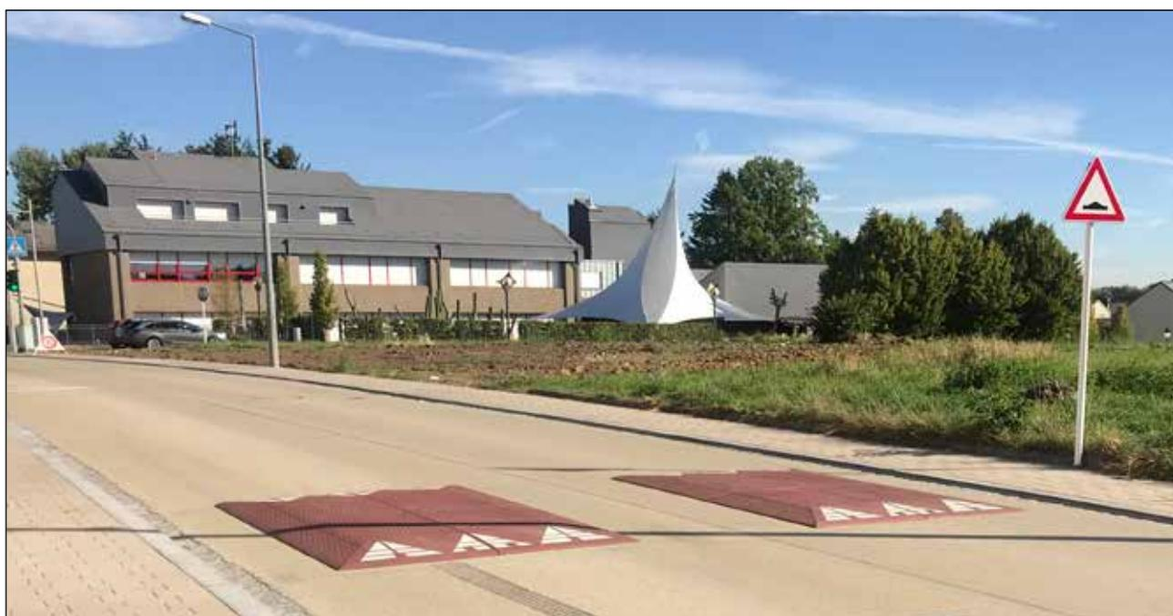
Exemple de ralentisseur - ralentisseur préfabriqué pour 30 km/h
