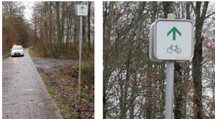
Abbildung 82: Montage der Zwischenwegweiser an einem Pfosten (1)
