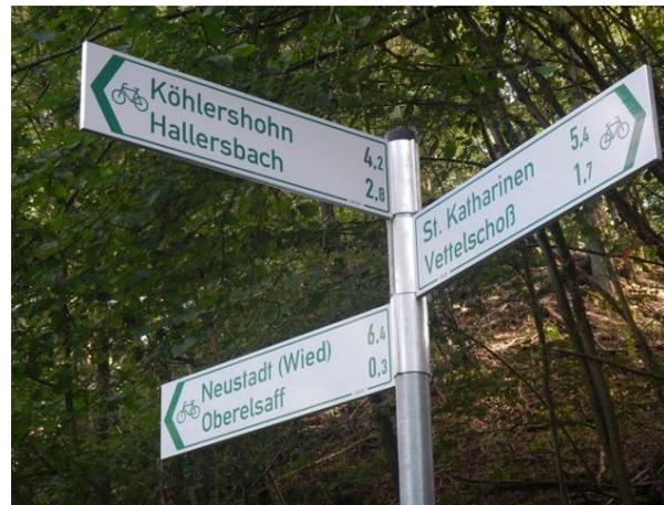
Abbildung 79: Leichte Eindrehung bei (gestufter) Montage von Pfeilwegweisern
