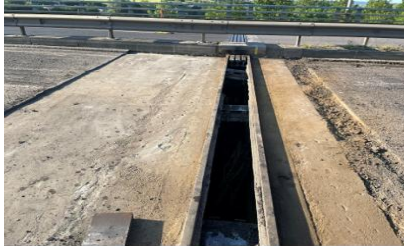
Enlèvement des joints existants
