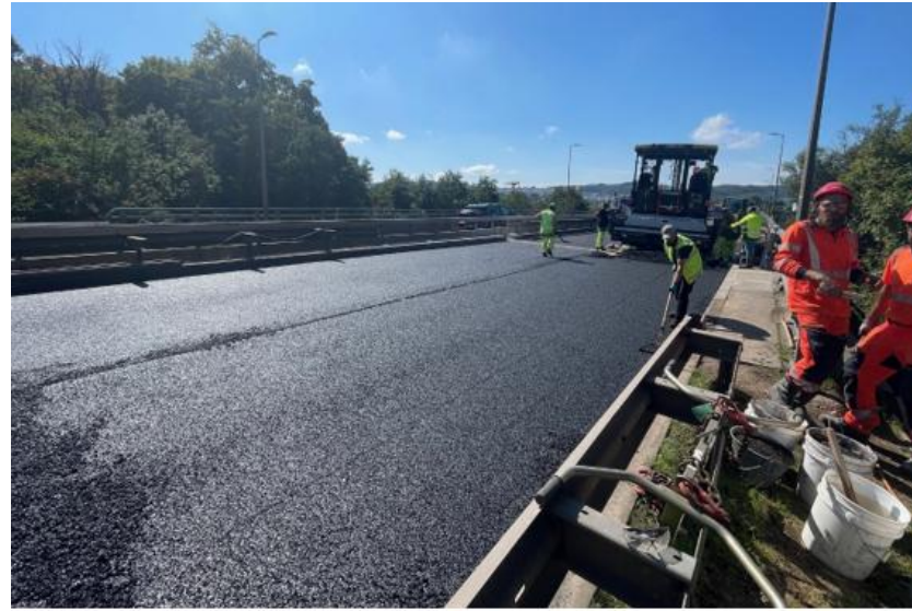
Travaux d'enrobé bitumineux
