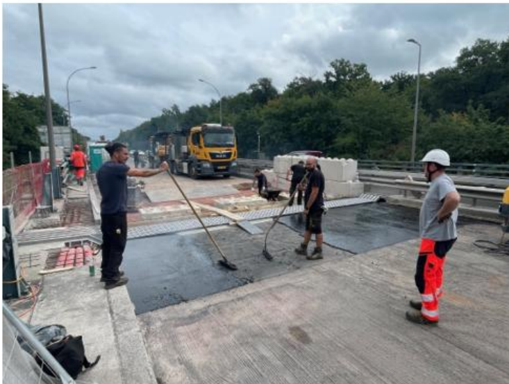
Travaux d'asphalte coulé
