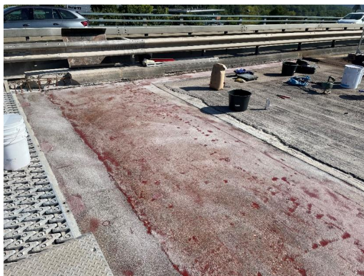
Réglage du joint de chaussée
