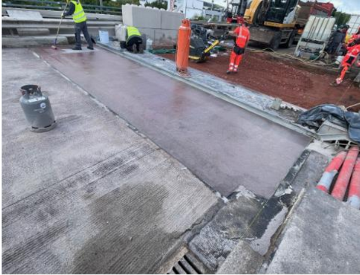
Travaux d'étanchéité
