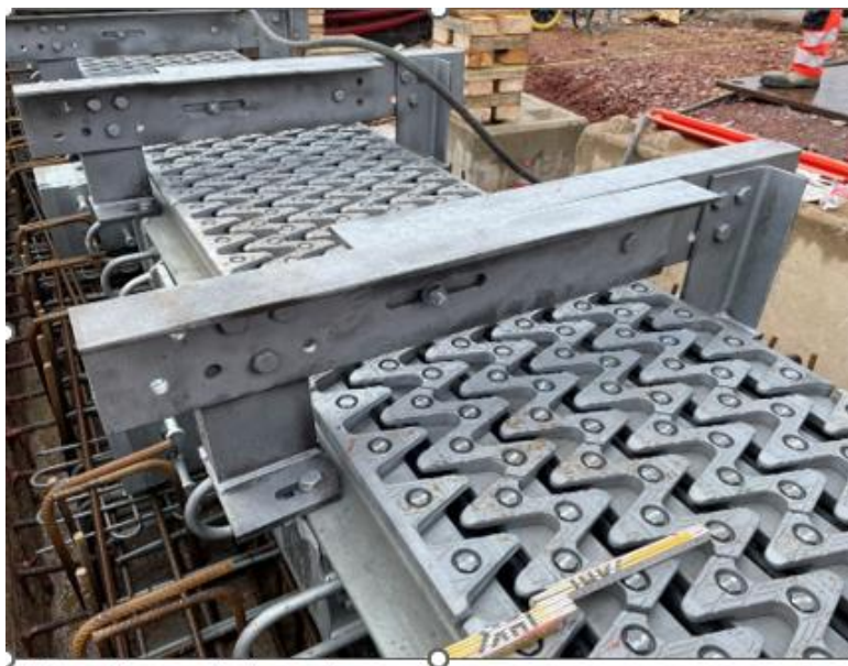
Réglage du joint de chaussée
