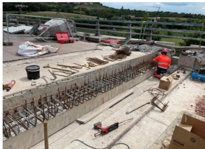
Ferraillages pour les ancrages des nouveaux joints de chaussée
