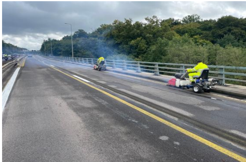
Travaux de démarquage et de marquage
