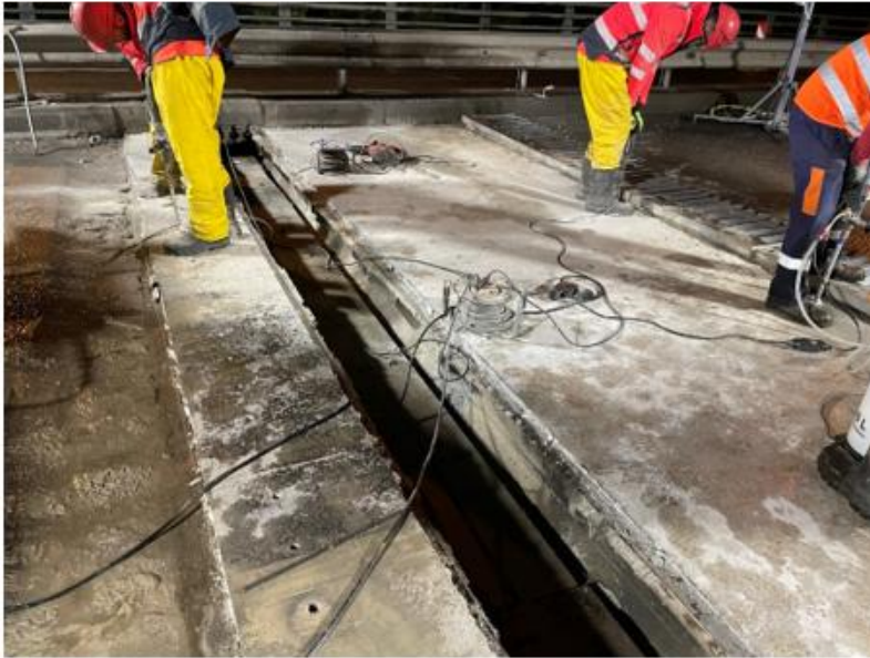
Préparation du support pour sceller les joints provisoires
