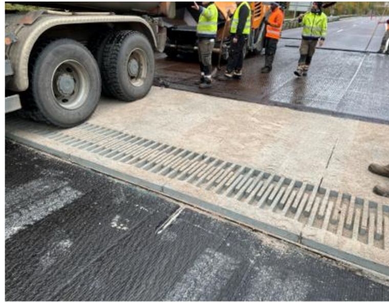
Travaux d'enrobés à la suite de la mise en œuvre des joints provisoires
