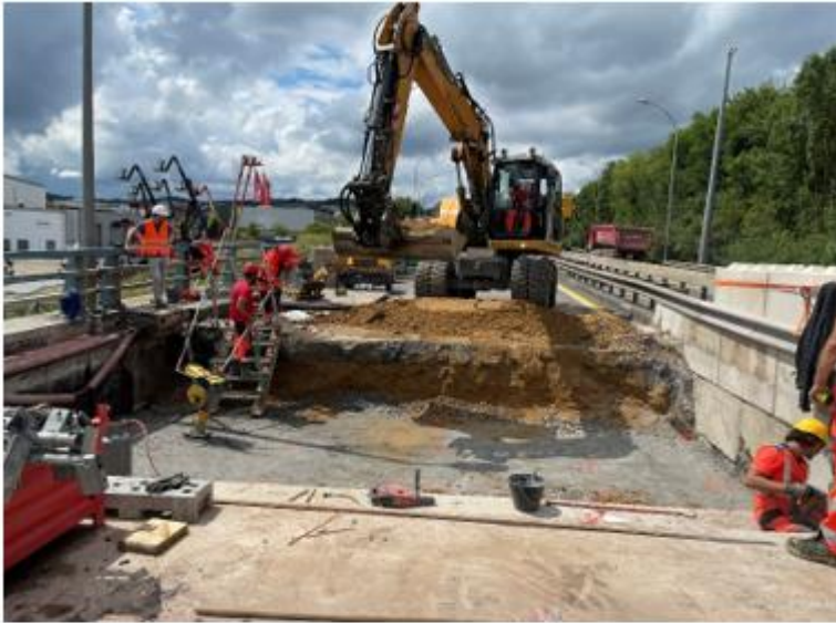
Travaux de terrassement
