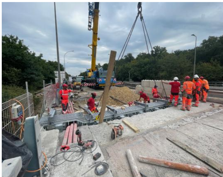
Levage du joint de chaussée à son emplacement définitif
